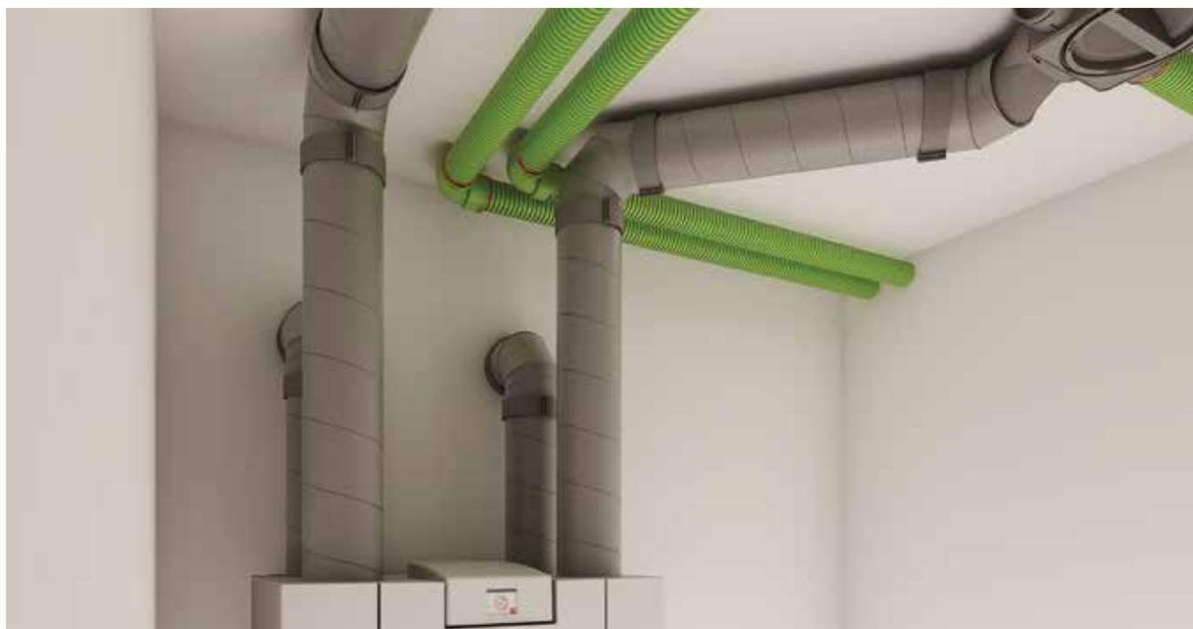
Pour éviter les pertes de chaleur et la condensation dans les systèmes de ventilation, de chauffage et de refroidissement de l'air, il est important d'utiliser des conduits bien isolés et étanches à l'air. Le système de conduits isolés Aerfoam est la dernière évolution en la matière. La gamme populaire est maintenant produite sans émission de CO<sup>2</sup> et une amélioration de la durabilité a été réalisée par rapport au système précédent.
